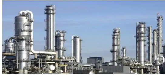
Torres de destilación fraccionada en una refinería.
