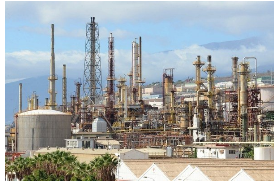
Refinería de Santa Cruz de Tenerife, en desuso y próxima a su desmantelamiento.
